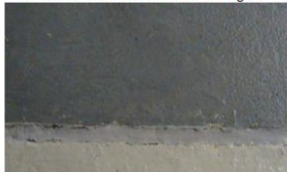
Joint de dilatation-Finition couleur grise
