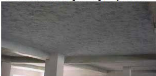
Isolation thermique - Après finition
