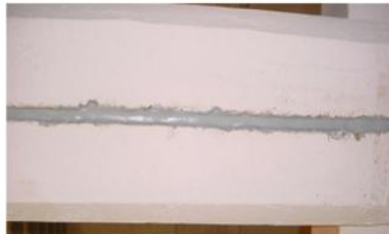
Joint de dilatation-Finition couleur grise
