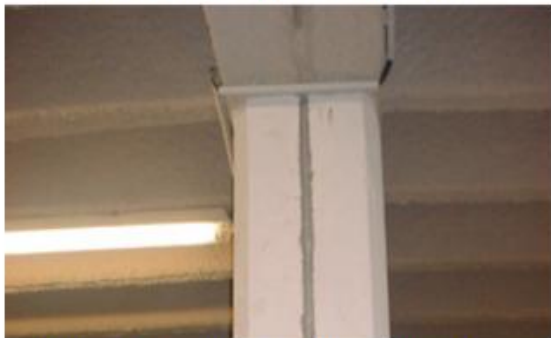
Joint de dilatation-Finition couleur beige
